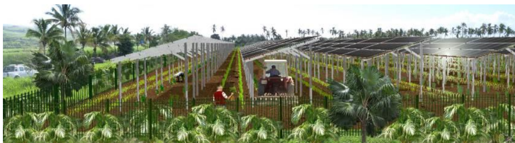
Figure 2 : Exemple de structures du même type, installées à La Réunion
